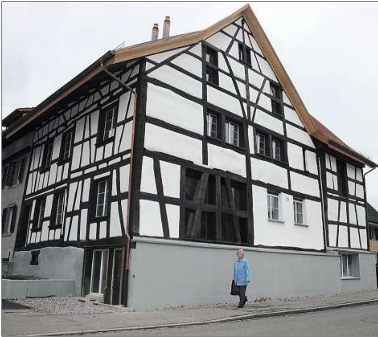
Eigentlich war die Trotte nur noch Bauschutt – doch Frank Keller und eine Handvoll Arbeiter haben sie neu aufgebaut. (hy)
