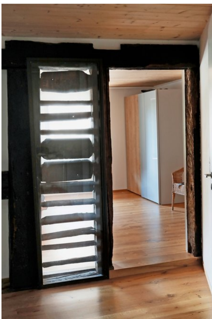
Gibt dem Raum Licht und Charme: Ehedem mit Stroh und Lehm verputzt, liegt die historische Wandkonstruktion nun hinter Glas.
