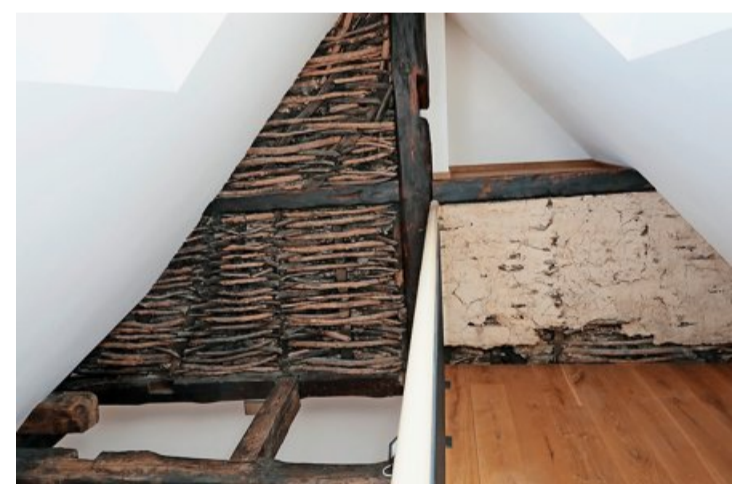
Dekorative Originalsubstanz: Weidenflechtwände schmücken die Galerie im Dachgiebel.
