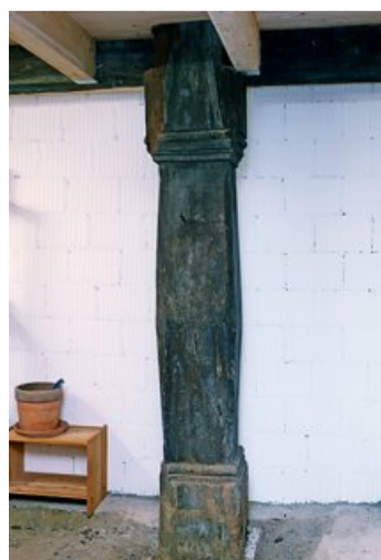
Der mächtige Eichenpfosten im ehemaligen Trottenkeller.
