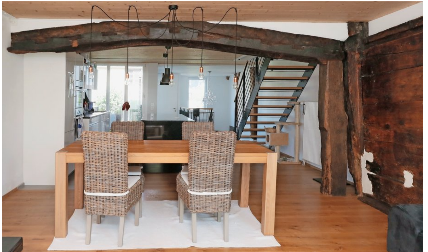
Früher die repräsentative Stube des Trottenmeisters, heute grosszügiger Wohn- und Essbereich: Der mächtige gebogene Balken weist Auflagenstellen für eine gewölbte Bohlenbalkendecke auf.
