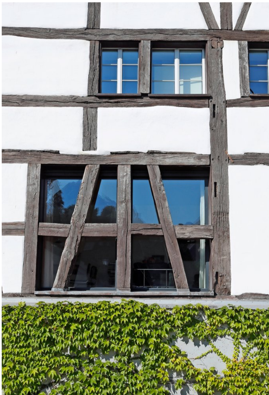
Die ehemalige Trotte Rafz befand sich in einem erbärmlichen Zustand, bevor sich der Architekt Franz Beat Keller ihrer annahm. Er hatte ihren bauhistorischen Wert erkannt und sie zwischen 2009 und 2012 saniert. Foto: Sibylle Meier SEITE 7
